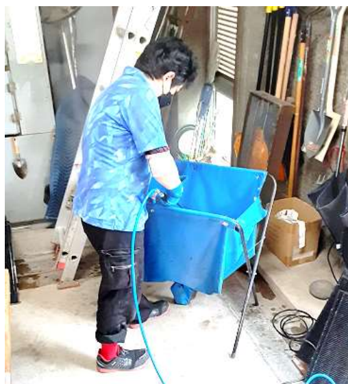
● 空調室内機・フィルター清掃
