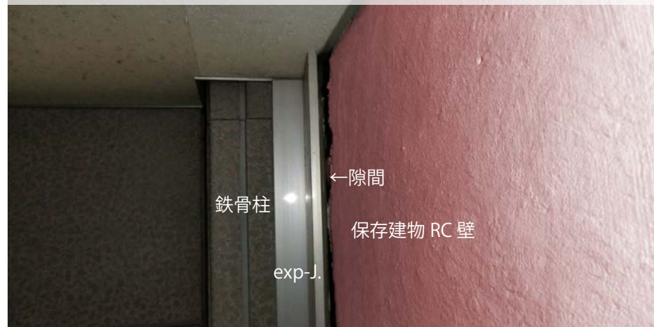
B 鉄骨梁が保存建物に接続（ひび割れ、剥落）
