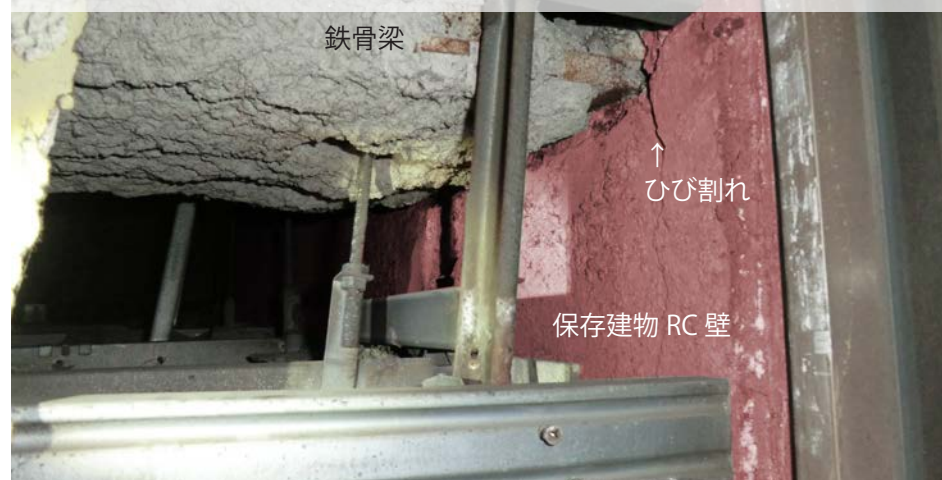
B 鉄骨梁が保存建物に接続（ひび割れ、剥落）
