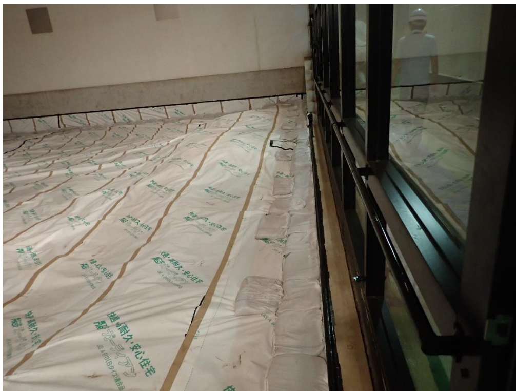
全面に透湿防水シートを設置 0917 撮影
