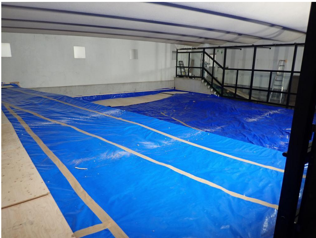
全面にブルーシートを設置 0929 撮影
