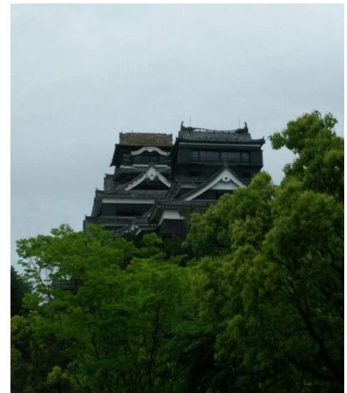
損傷した熊本城天守閣 1
